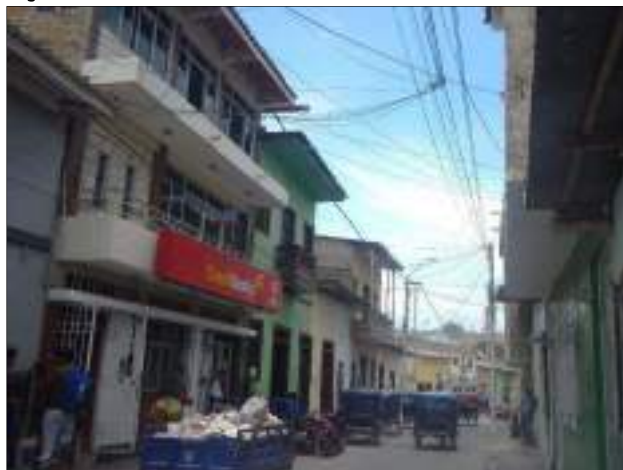
Imágen 1.3-19. Provincia de Paita: Instalaciones de Cableado Aéreo
